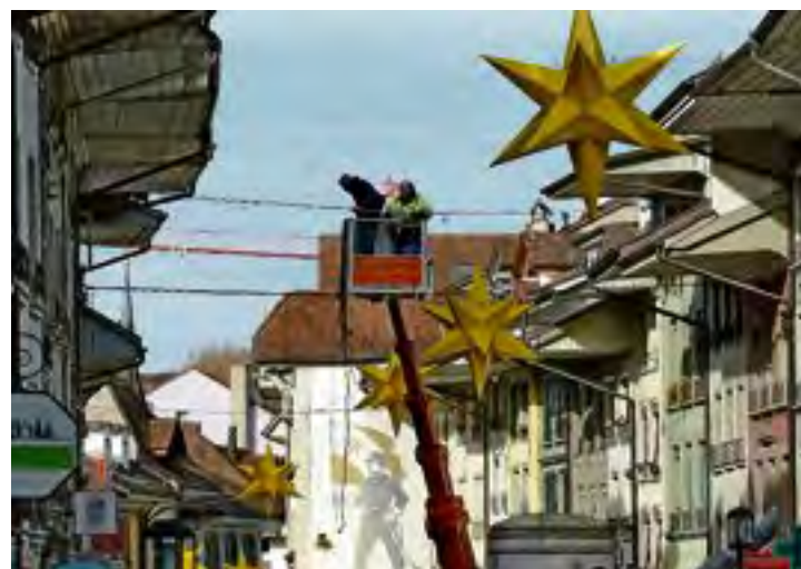
Anfang Woche wurde in der Oberen Hauptgasse in Thun wieder die Weihnachtsbeleuchtung montiert.
